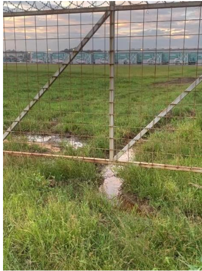
Gambar 2. Jalan dari baseops menuju taxiway E
