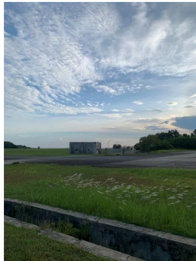
Gambar 1 Pagar perimeter pembatas dekat runway 25
