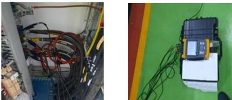
Gambar 2. Pemasangan Power Quality Meter
