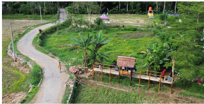
Gambar.4 Pembangunan sarana pendukung
