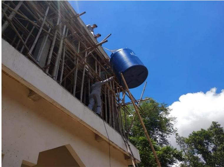
Gambar 2. Pemasangan Water Torn
