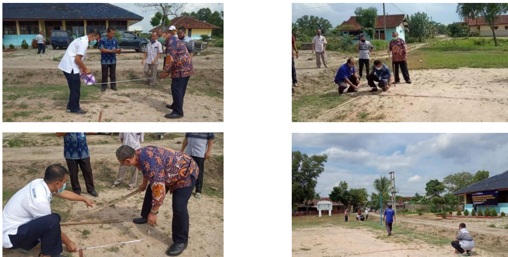
Gambar 9. Pengukuran ulang lokasi pemasangan paving block
