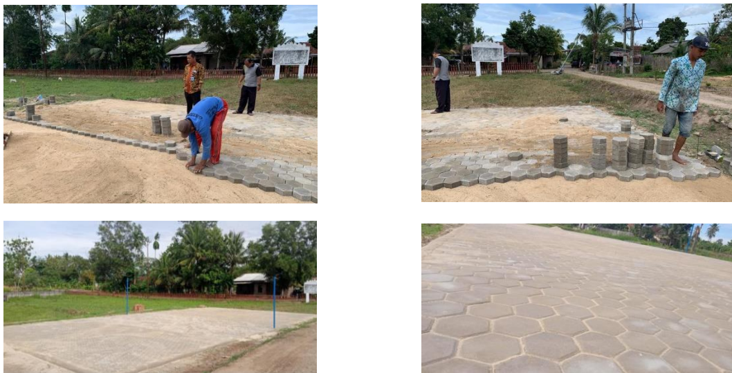
Gambar 14. Proses pemasangan paving block dan hasilnya
