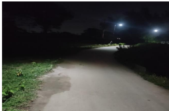
Gambar 7. Kondisi Sesudah Pemasangan Unit Lampu
