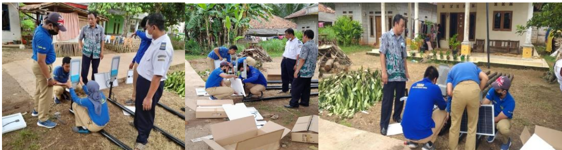
Gambar 4. Pelaksanaan Pemasangan Unit Lampu Serta Solar Cell Pada Unit Tiang
