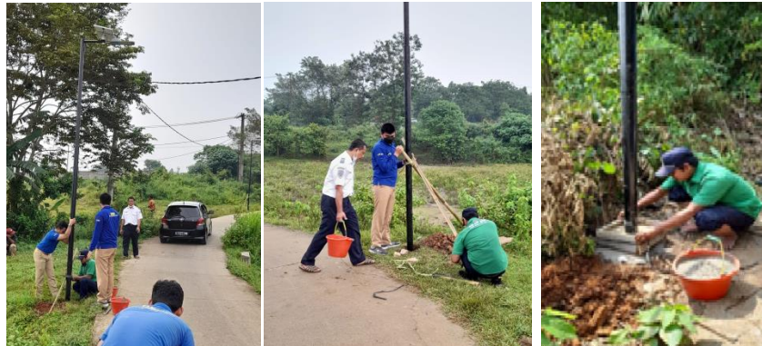
Gambar 5. Proses pemasangan tiang pada lubang tanam
