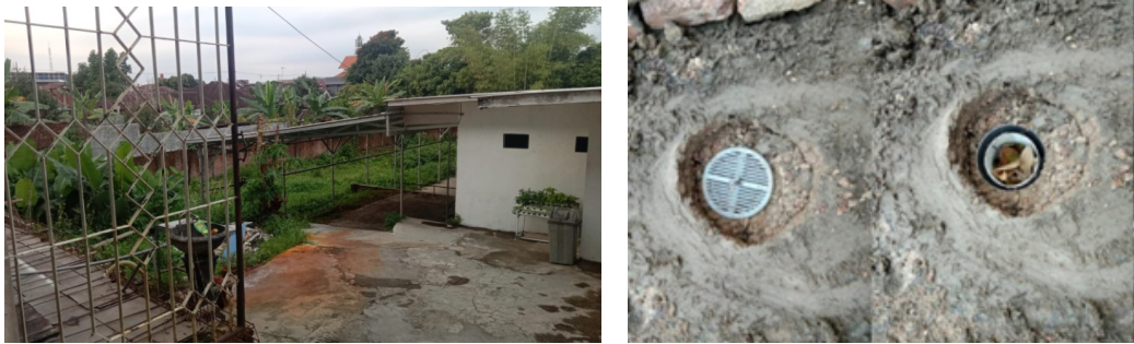
Gambar 2: Pemasangan LRB di halaman sekolah
