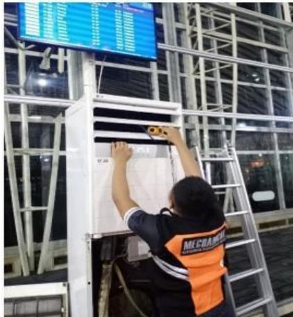
**Gambar 6.** Pengukuran hembusan pada *exhaust*
