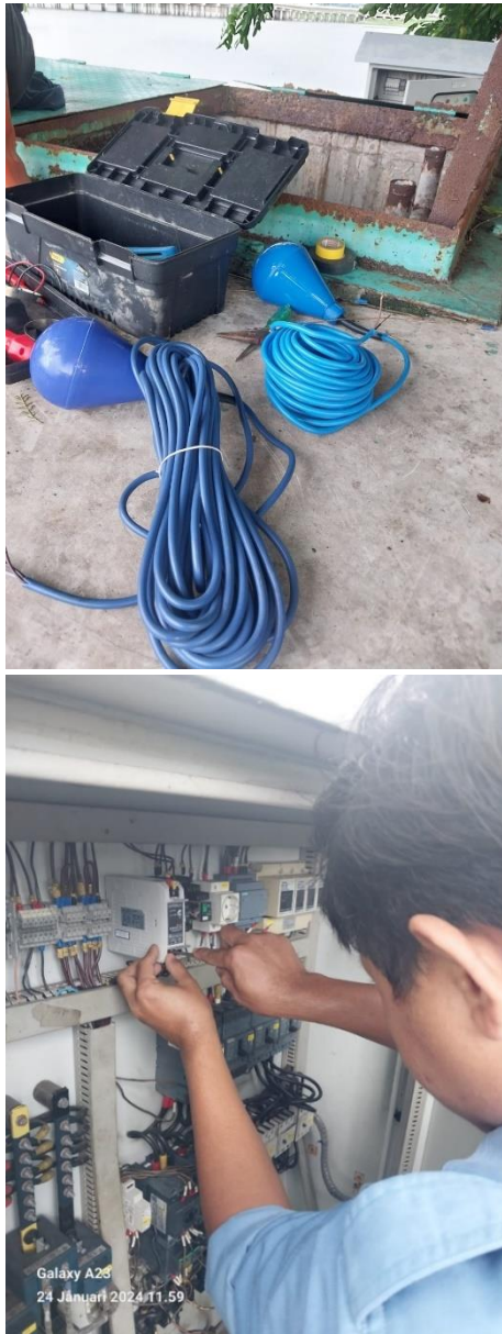
Gambar 4. 6 : Analisa permasalahan dengan menggunakan multimeter dan pengecekan kontinuitas NC/NO pelampung
