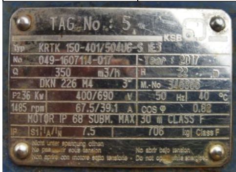
Gambar 3. 2 : Nameplate pompa LP 10 Sumber : Dokumen penulis, 2024
