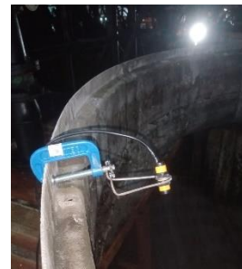
Gambar 8. Dokumentasi Pemasangan Sensor pada cooling tower
