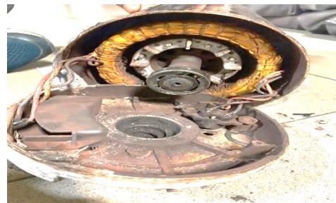
Gambar 10 Bearing yang aus pada motor fan
