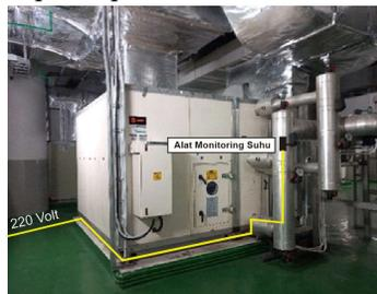
Gambar 6. Desain Pemasangan Alat Monitoring Suhu pada AHU
