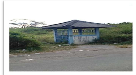
Gambar 8 Pos di Sebrang Ujung Runway 08 yang Sudah Tidak digunakan
