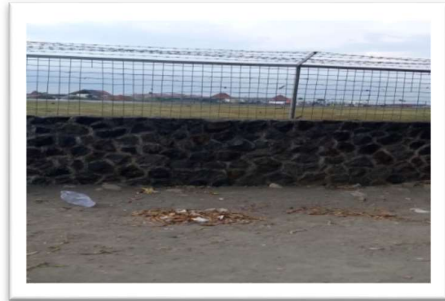
Gambar 1 Pagar Perimeter di Sisi Selatan Runway 08
