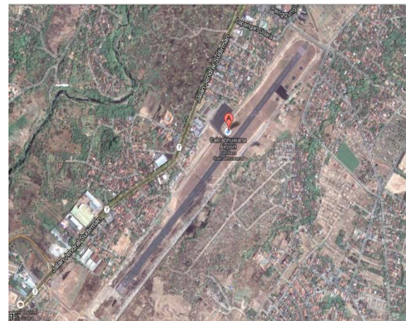
Gambar 1. Bandar Udara Cakrabhuwana
