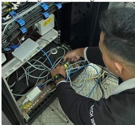
Pemasangan VDSL (CO Mode) di Gedung TX Sumber : Dokumentasi Penulis
